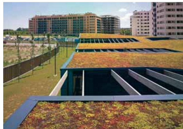
Escuela Infantil Oliver, Zaragoza. Santiago Carroquino | Arquitectos. Fotografía: Jesús Granada.
