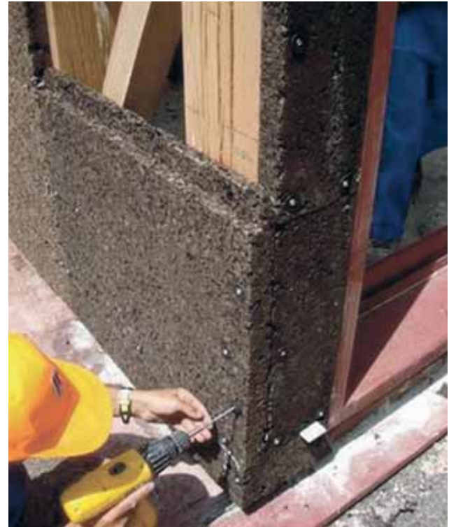
Aislamiento térmico con láminas de corcho.
