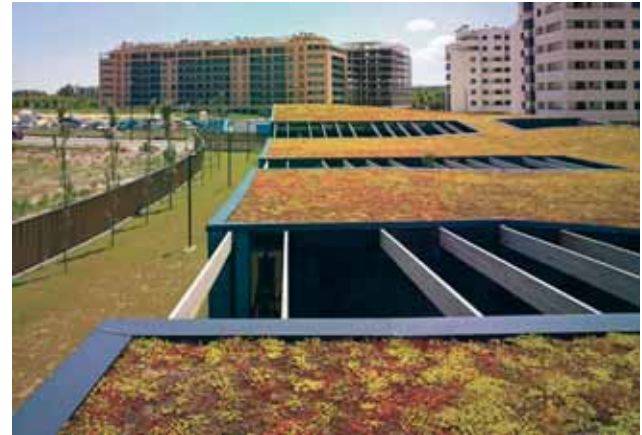
Escuela Infantil Oliver, Zaragoza. Santiago Carroquino | Arquitectos. Fotografía: Jesús Granada.
